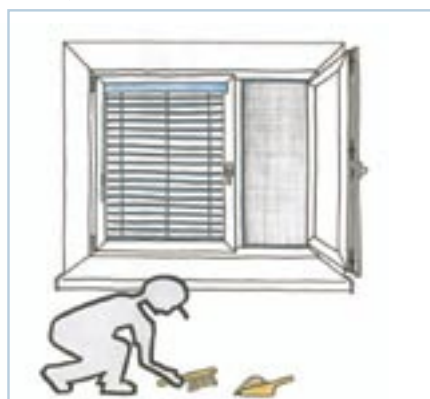
6. Očistenie a nastavenie okna, montáž doplnkov a upratanie priestoru okolo okna
